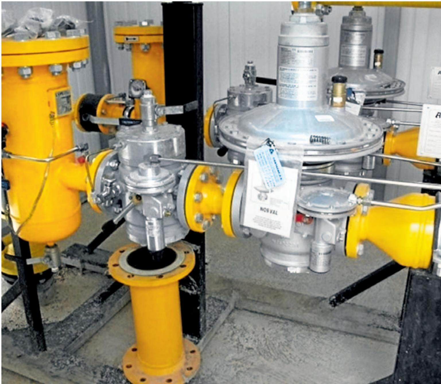
Imagen del interior de una estación de regulación y medida de distribución de gas natural.
